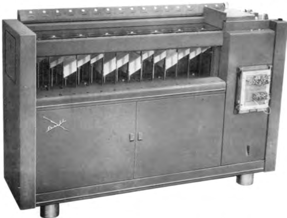
Sortermachine D 3. Elektronische machine voor numeriek en alfabetisch sorteren. Bij alfabetisch sorteren wordt meer dan de helft der kaarten gesorteerd in de eerste doorgang, de overige gaan naar het restvak en worden gesorteerd in de tweede doorgang. Door een schakelbord kan willekeurig het verband worden gelegd tussen de uit de kaarten af te tasten ponsingen en een bepaald sorteervak.
