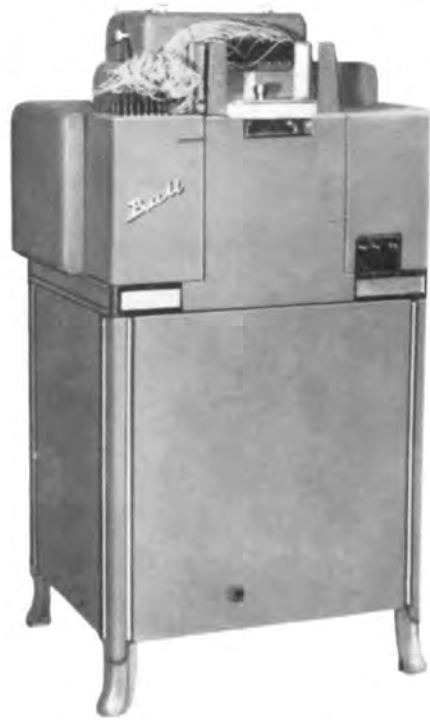
Vertolker. Drukt in gewone letters op de bovenste rand van de ponskaart de gegevens (b. v. woorden) af die in de kaart in de vorm van ponsingen door de ponsmachine zijn aangebracht.
